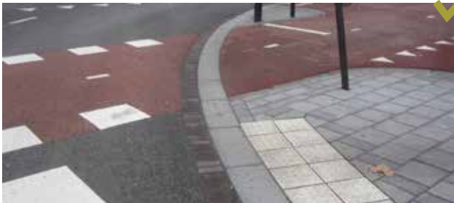
Juiste detaillering van een 50 km/uur kruispunt.
