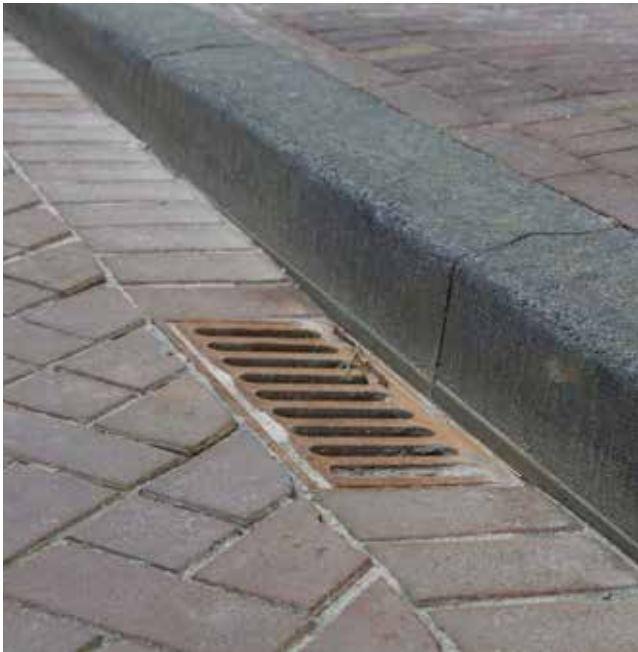
De 45x20 straatkolk met schuine kop, in rollaag.
