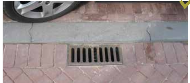
Detail van goede toepassing van een 45x20 straatkolk met rollaag
