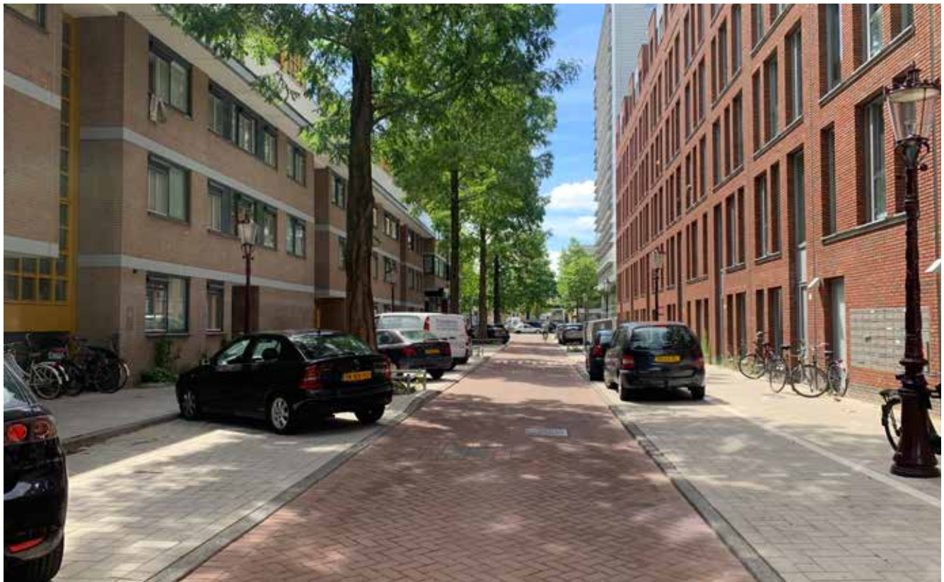
De Tilanusstraat. Een eenvoudige maar hoogwaardige inrichting voor een erftoegangsweg, conform de Puccinimethode, model Modern, links met 'tussenband', rechts zonder.
