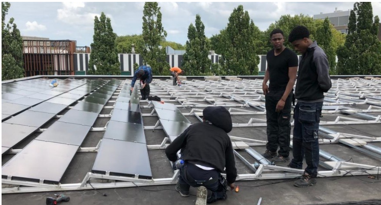
Figuur 17: Installeurs aan het werk bij de installatie van 800 weespanelen op het Marineterrein (Bron: Zuiderlicht)
