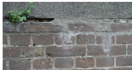
Figuur 11 - Oud metselwerk kademuur Herengracht, vormbaksteen met een traskalkvoeg, een deksteen van beton. Oppervlak is vervuild, verweerd, heeft patina en er groeit flora in de muur (Foto MenA, 2019)
