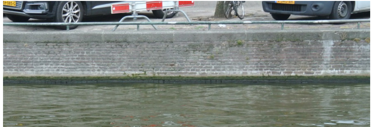
Figuur 9 - Kademuur aan de Herengracht (Foto MenA, 2019)
