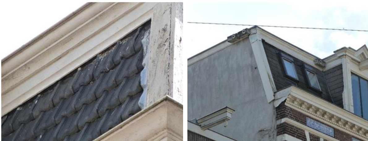
Foto 2 en 3. Een 19 e -eeuws dakschild met originele dakpannen (kruispan, links) en een dergelijk dakschild waar de dakpannen zijn vervangen door bitumen shingles (rechts). Bij de invliegopening van een nest zijn vaak poepsporen te zien (links). In stadsdeel West zijn veel beugelkasten opgehangen door Gerard Schuitemaker van de Gierzwaluwwerkgroep Amsterdam (foto's Eerste Helmersstraat).
