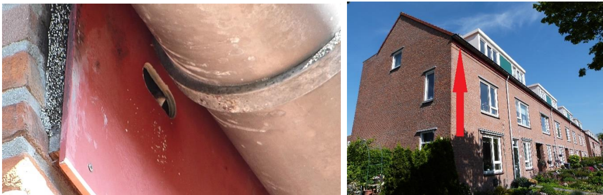
Foto 42 en 43. In de Sint Josephlaan werden bij een renovatie nestkasten onder de dakgoot, achter een boeiboord, ingebouwd/geïntegreerd. Op de foto links kijkt een jong naar buiten, herkenbaar aan de witte keel. Dit voorbeeld van Natuurinclusief bouwen is een groot succes, de 50 nestkasten zijn bijna allemaal bezet, met de laatste jaren rond de 40 broedparen (info Gierzwaluwwerkgroep Amstelveen).
