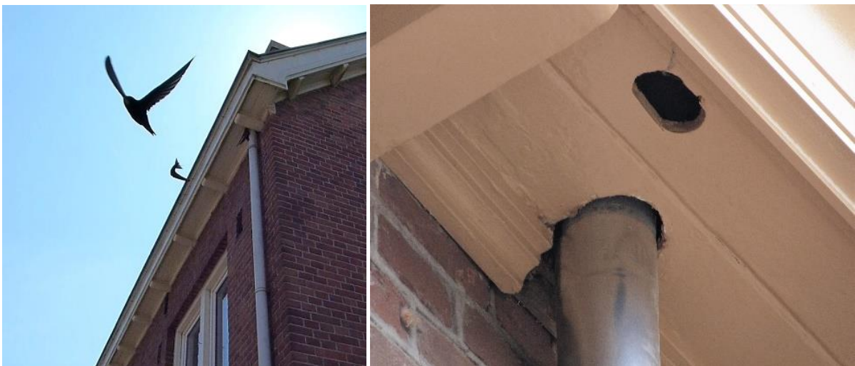
Foto 26 en 27. In Volewijck (Van der Pekbuurt) broeden gierzwaluwen in gootbekistingen, voor de renovatie van 2016. Bij de renovatie zijn kunstmatige invliegopeningen gemaakt op advies van de ecooloog (Regelink, ingehuurd door woningcorporatie Ymere), ter mitigatie (foto links bangers bij een actief nest in Anemoonstraat 10, 12 juni 2015).
