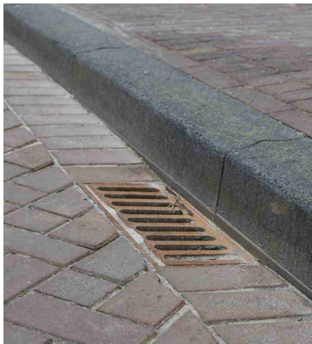
De 450x200 straatkolk met schuine kop, in rollaag.
